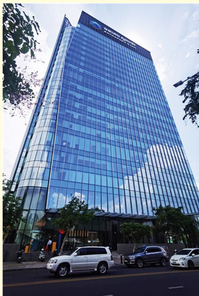
2021年1月 新本社ビル「サタパナタワー」にて営業開始
